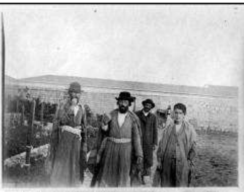
בתמונה רואים את רבי יעקב מן על רקע בית החולים שערי צדק במהלך בנייתו, לקראת קבלת הקיזור וילהלם השני בביקורו בארץ ישראל
